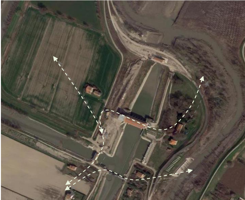
5 – manufatti idraulici elementi di deframmentazione sul canale di presa sul Secchia all'interno del corridoio primario del PTCP e della RER.
