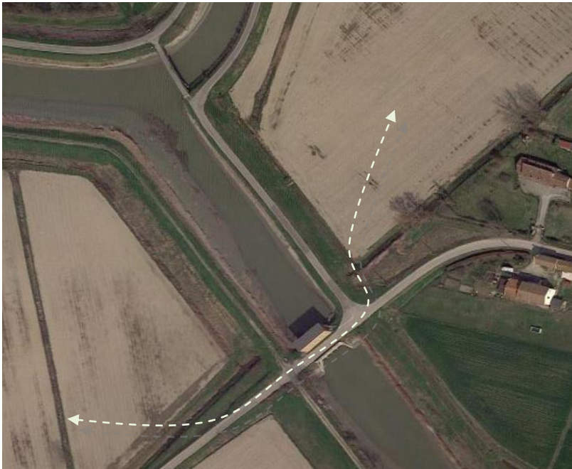
4 – ponte stradale e manufatto idraulico elemento di deframmentazione sul canale di presa sul Secchia all'interno del corridoio primario del PTCP.
