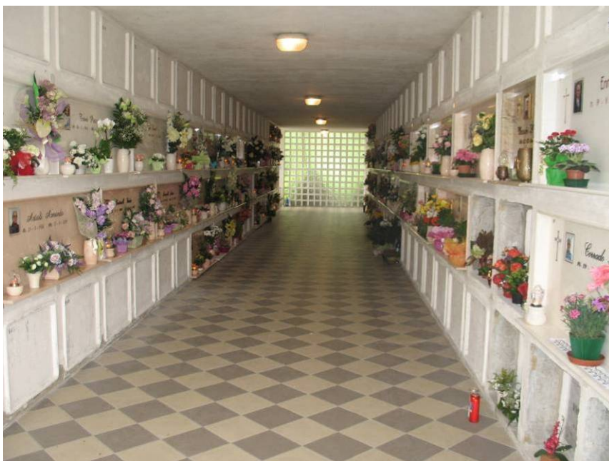
Foto n°8b. Galleria porticata chiusa del recente ampliamento cimiteriale al quale il presente intervento ne riprenderà tipologia e ingombri. La vetrata in vetro cemento sarà demolita per creare il collegamento.
