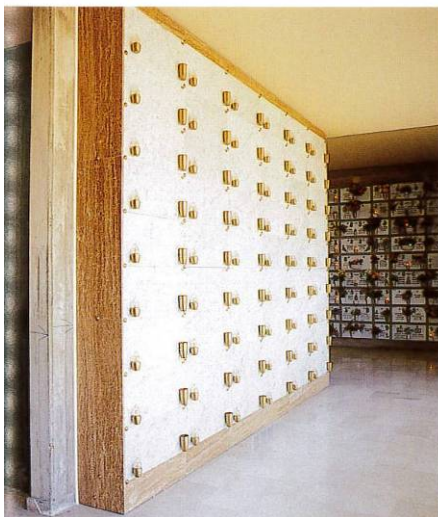
Foto n°2. Esempio di realizzazione di cinerari e ossari con metodologia prefabbricata.
