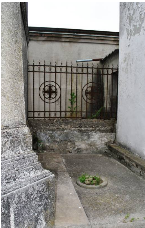
Foto n° 4b. Particolare della zona ove è previsto l'accesso al retrostante deposito.
