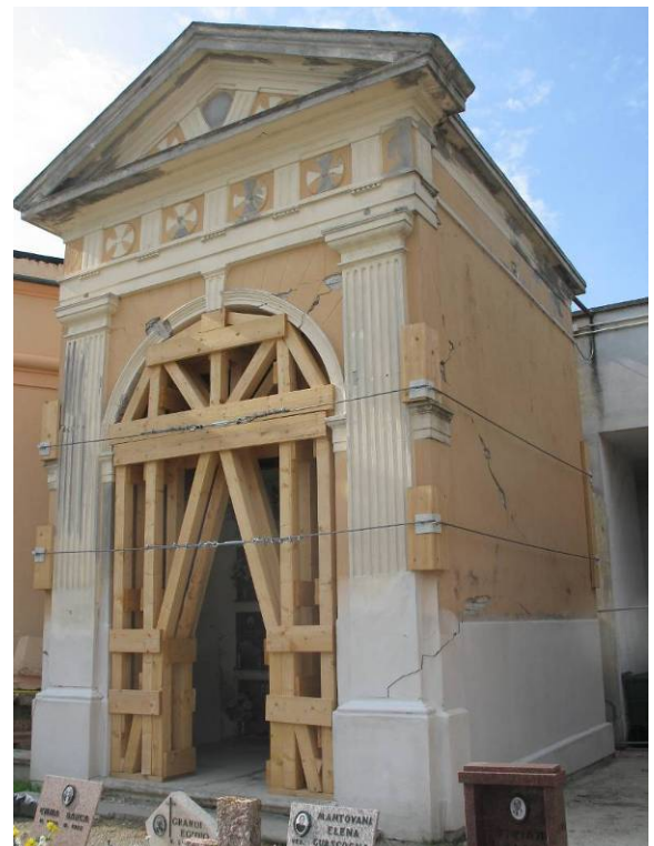
Foto 1 a , 1b. Esempi azioni di consolidamento provvisorie su manufatti cimiteriali che necessitano di interventi strutturali e di restauro definitivi
