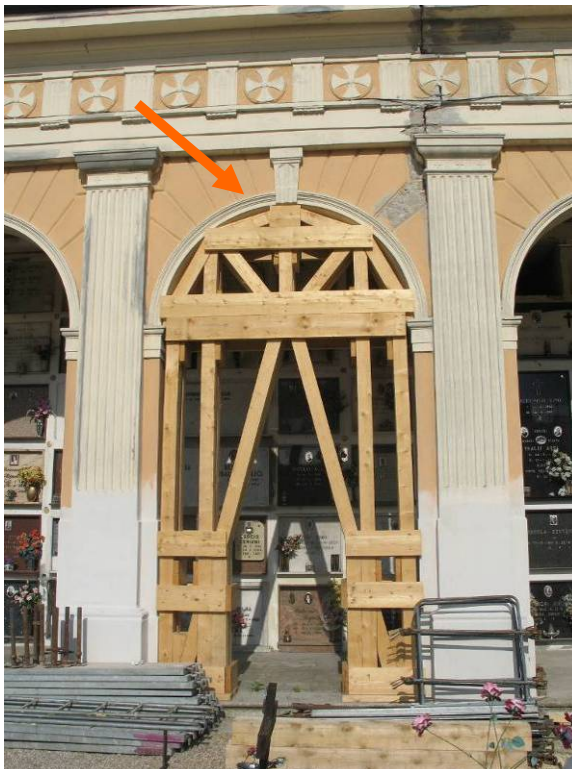
Foto 1 a , 1b. Esempi azioni di consolidamento provvisorie su manufatti cimiteriali che necessitano di interventi strutturali e di restauro definitivi
