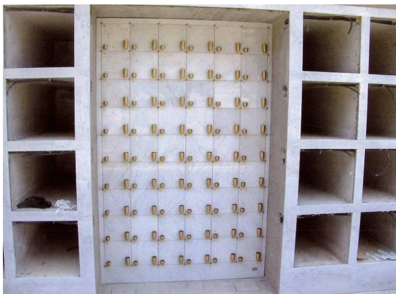
Foto n°2. Esempio di realizzazione con metodologia prefabbricata.
