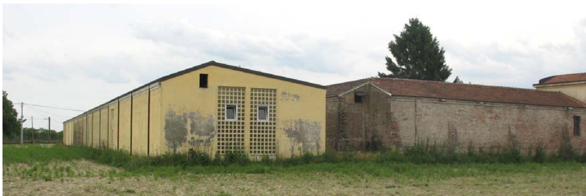
Foto n° 4c. Esempio tipologico considerato per ipotesi progettuale di ampliamento: ampliamento esistente su lato nord del plesso
