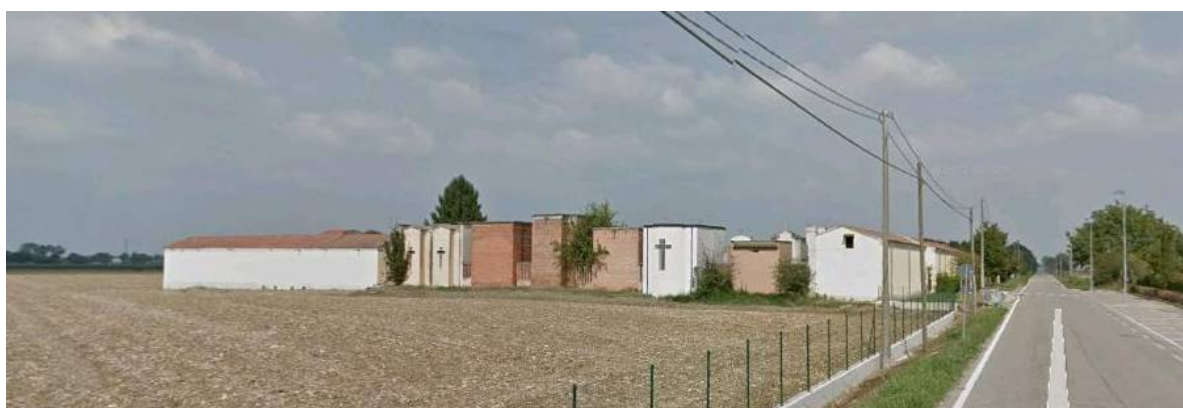
Foto n° 4b. Area individuata per l'ampliamento: in adiacenza al muro perimetrale lato sud.
