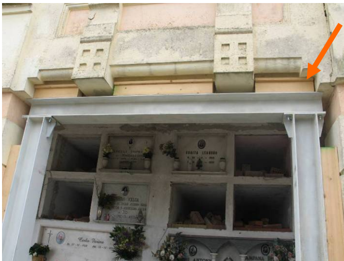
Foto n° 1a e 1b. Esempi di azioni di consolidamento provvisorie (o comunque volte alla sola messa in sicurezza e sicuramente non attente all'aspetto architettonico e di tutela del manufatto storico) già eseguite sui manufatti cimiteriali.
