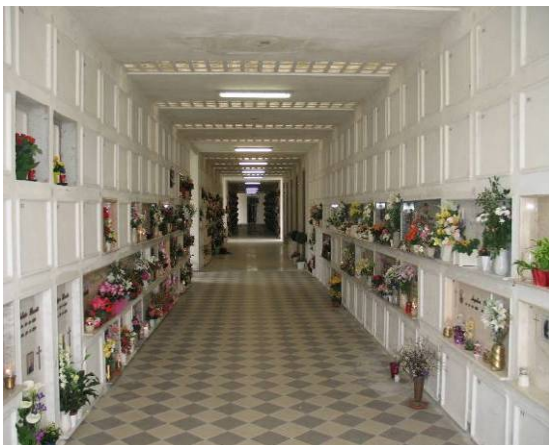
Foto n° 4d. Esempio tipologico considerato per ipotesi progettuale di ampliamento: galleria porticata chiusa (a sinistra) e galleria porticata (a destra) entrambi con loculi disposti di punta su quattro livelli sovrapposti.
