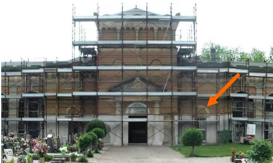
Foto 4a. Vista dall'esterno del Deposito Mortuario/ Osservazione (vedi freccia).
