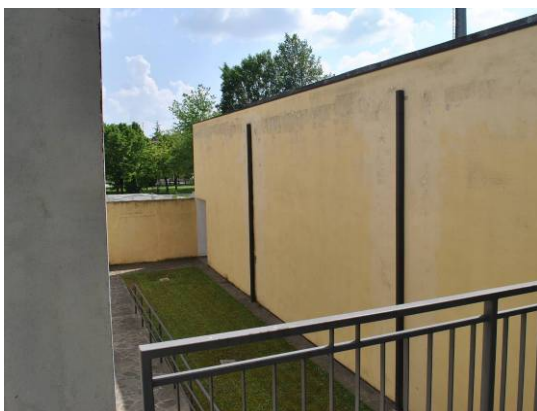
Foto n°6b. L'area individuata per l'ampliamento è adiacente al muro perimetrale lato ovest. Il nuovo manufatto sarà in prosecuzione dell'esistente (a destra in foto). Il muro di cinta, al centro dell'inquadratura, sarà demolito per garantire uno dei collegamenti con l'esistente.
